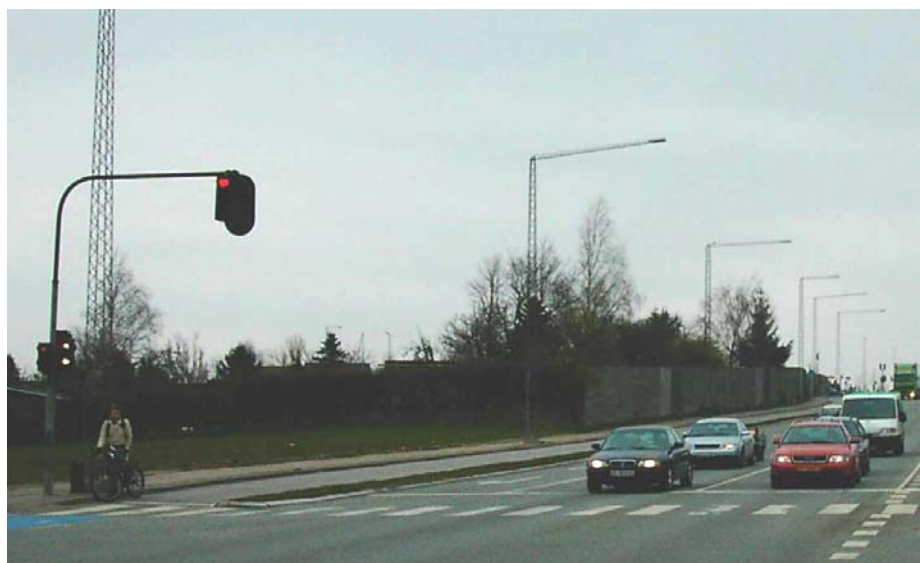
Figur 11: Kontrollampe lyser ved rødt signal
